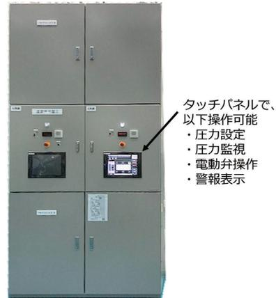
図8 自動ガス充排気装置制御盤
