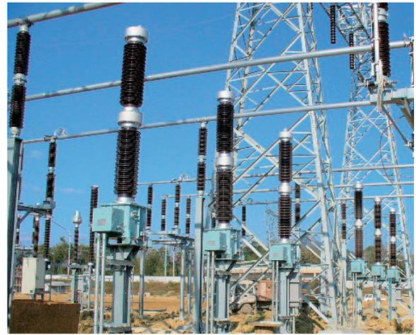
図3 230kV CVT (タイEGAT納入)
