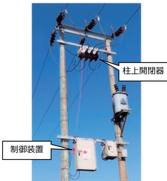
図1 配電自動化システム（プロトタイプ）
