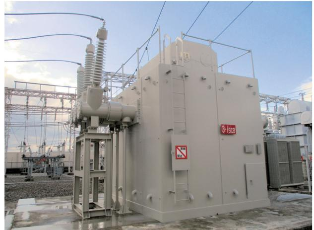
図1 77kV 20Mvar大地置オールフィルムコンデンサ設備
