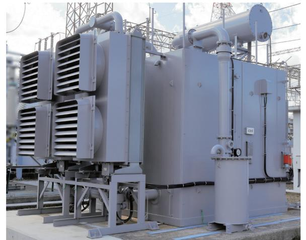
図2 分路リアクトル (60kV 80Mvar 60dB) <sup>201910③</sup>
