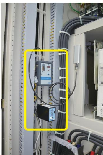
図2 複合環境センサ+部分放電検出センサ
