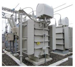
図2 不平衡補償装置用リアクトル
