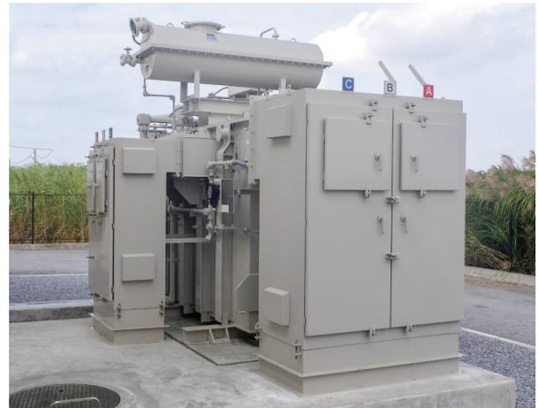
図2 配電用変圧器
