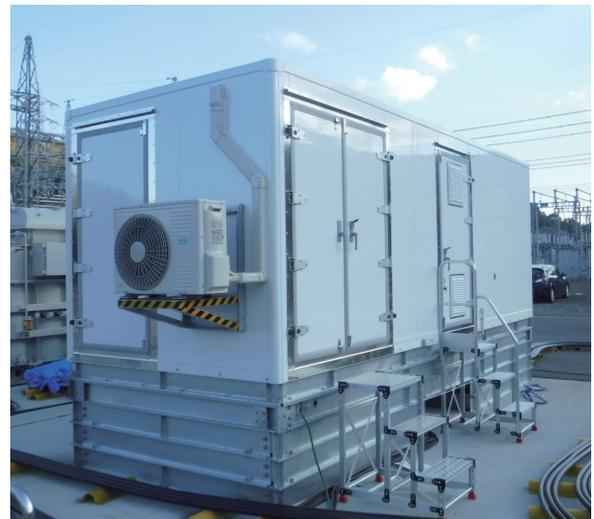
図1 7.2kV移動用スイッチギヤ室
