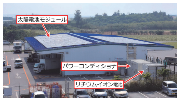
図4.2 ハイブリッド電源システム全景
