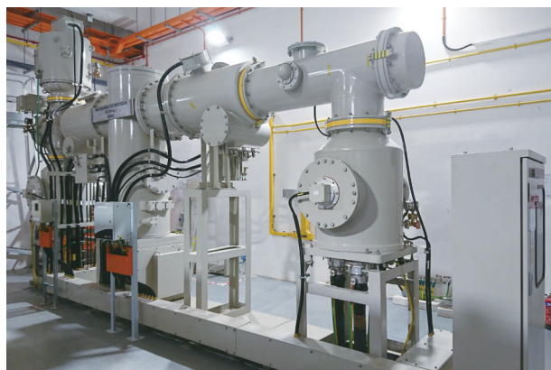
図 1 66kV ガス絶縁開閉装置
