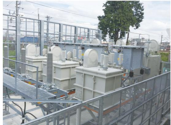
図3 高調波フィルタ（写真提供：JR東日本）
