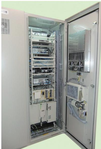
図9 腐食性ガス対策
