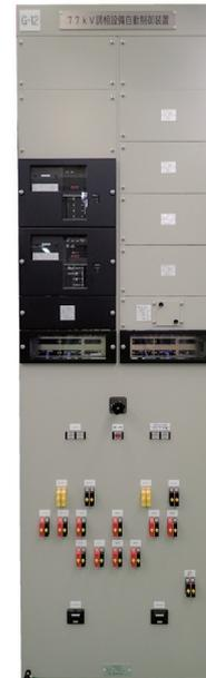
図5 デジタル形調相設備自動制御装置
