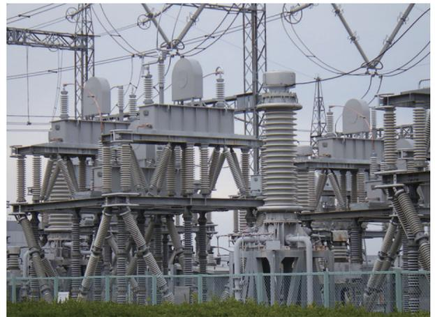
図1 275kV交流フィルタ設備
