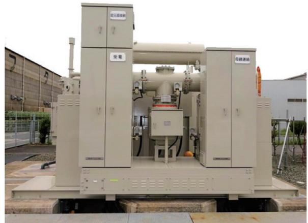
図3 緑ヶ浜変電所納入 84kV配電用変電所用C-GIS
