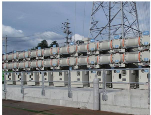
図4 <sup>つかま</sup>筑摩変電所納入 84kV新縮小形GIS
