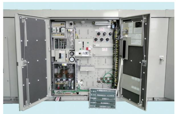
図2 6.6kV環境配慮型受電装置外観（受電盤内）
