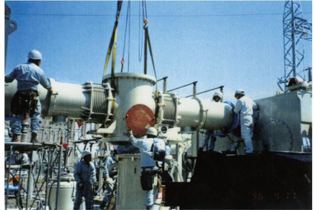
図5 A-GIS変電所作業状況
