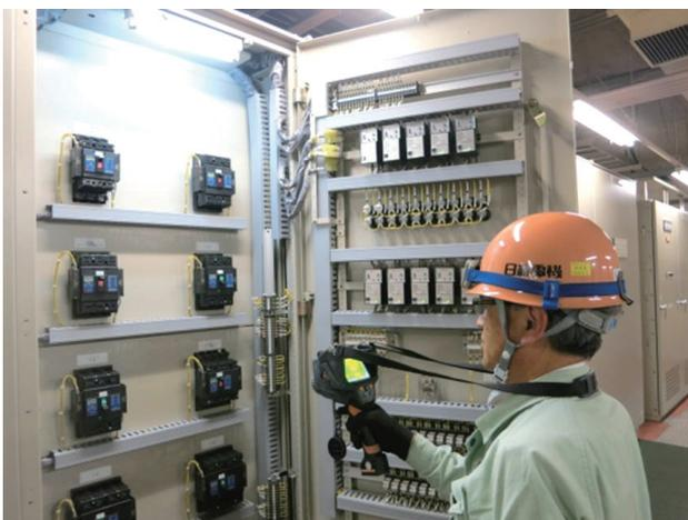
図19 設備診断 (配電盤内部の温度分布測定)
