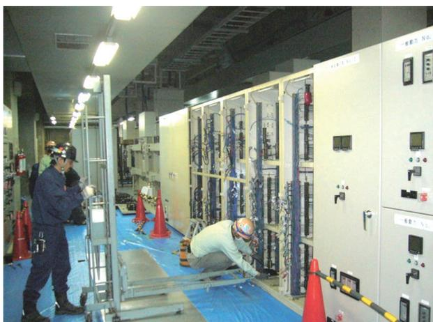
図15 配電盤 内部機器、扉更新作業
