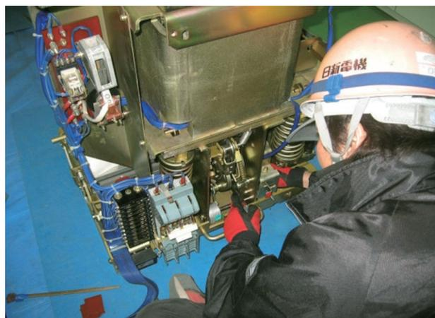
図17 遮断器の精密点検
