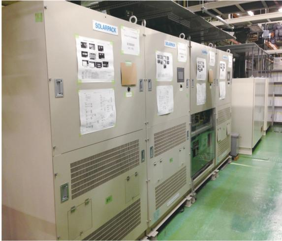
図6 500kW器対応検査設備用再生電源盤
