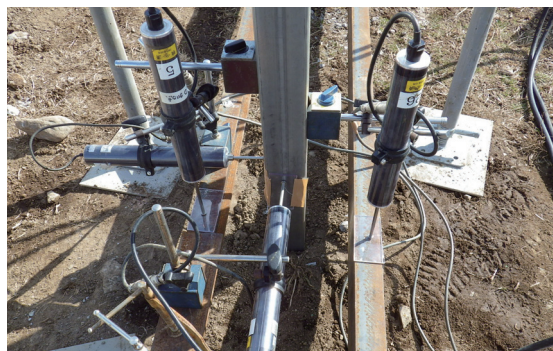
図 3.2.7(a) 杭基礎引抜試験状況
