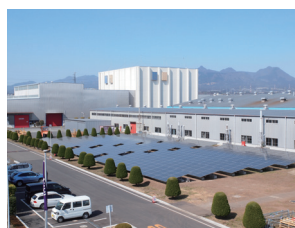
図 3.2.6(a) 地上設置全景
