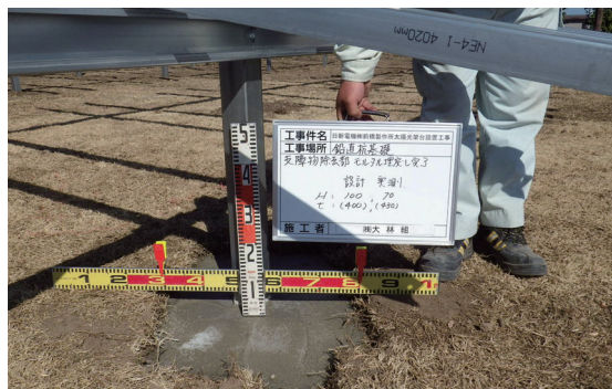
図 3.2.7(b) モルタル打設による引抜強度対策
