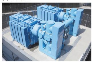
図4 77kV受変電設備
