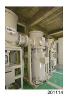
図5 77kV 受変電設備
