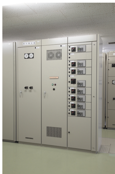
図4 インテリジェントコントロールセンタ
