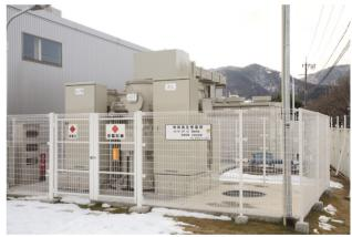
図3 77kV 受変電設備
