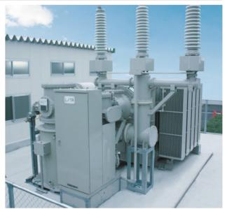
図4 66kV受電設備
