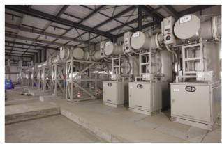
図1 154kVガス絶縁開閉装置
