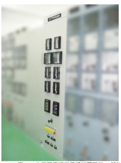
図14 変圧器保護用保護継電器盤
