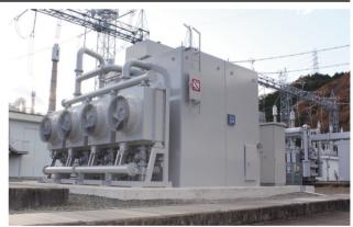
図3 分路リアクトル 66.5kV 100Mvar 65dB
