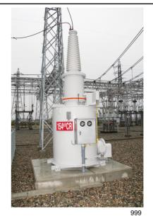
図2 ガス絶縁中性点リアクトル 154kV 10MVA 定格時間10秒
