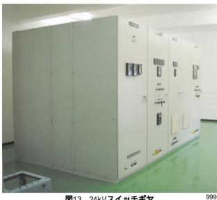
図13 24kVスイッチギヤ
