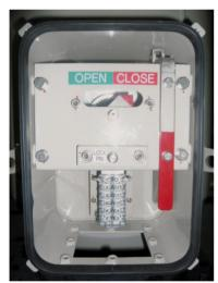
図4 単相ID付きガスVT 手動操作器
