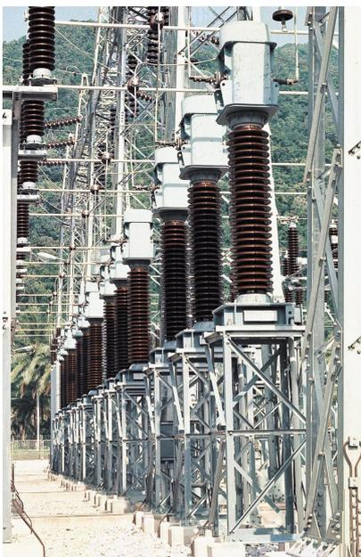
図9 115kV倒立形CT 58-5
