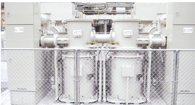
図4 84kV超縮小形ガス絶縁開閉装置
