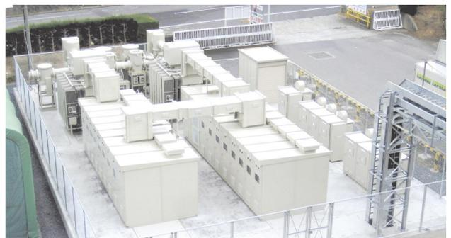
図5 77kV受変電設備
