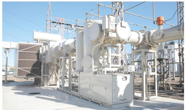
図3 168kV縮小形ガス絶縁開閉装置（東京鐵鋼株式会社）
