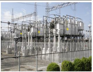
図2 関西電力株式会社殿 城端開閉所 直列コンデンサ設備
