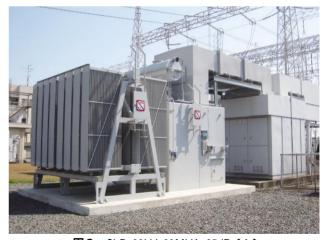
図3 ShR 33kV 60MVA 65dB (A) (中部電力株式会社殿 東名古屋変電所納入品)
