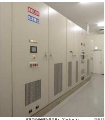
高圧用瞬低停電対策装置(パワーセーフ)
