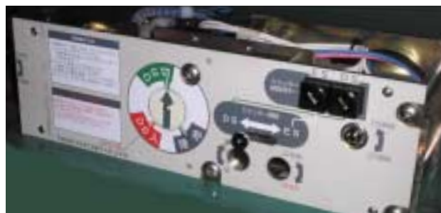
図9 ロータリー式3位置断路器 / 接地開閉器用電動操作器
