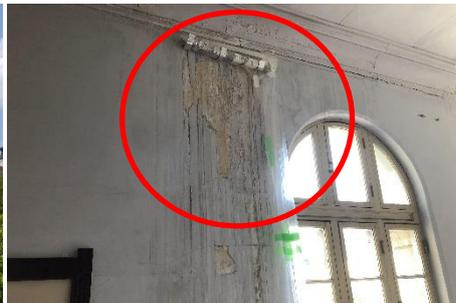
雨水の染み出しにより壁面が毀損
