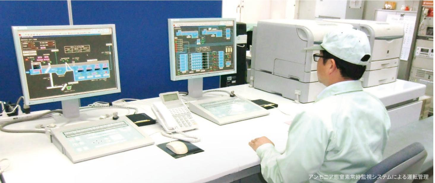
アンモニア態窒素常時監視システムによる運転管理
